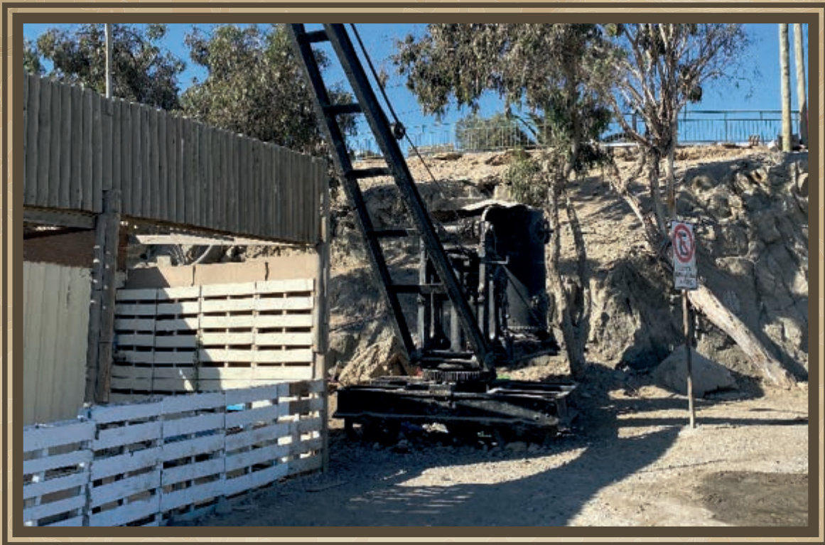
Frontis Estación FFCC Año de construcción: antes de 1906
